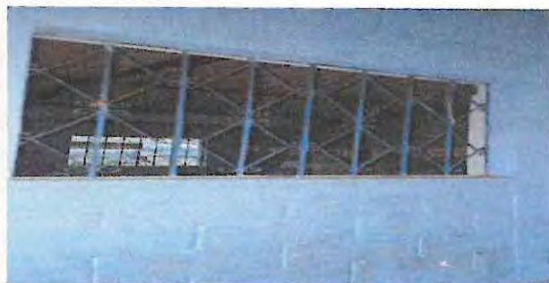
Foto 6: Mantenimiento de ventanas.
